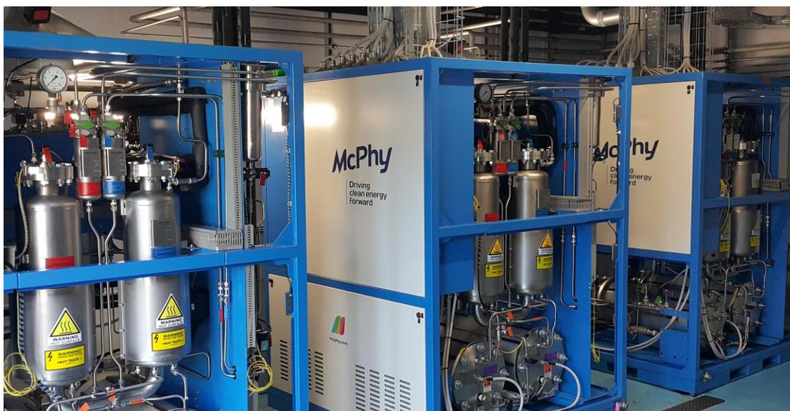
Unité de production industrielle d'hydrogène renouvelable | Trois électrolyseurs McPhy fournissant 30 Nm<sup>3</sup>/h en nominal et 50 Nm<sup>3</sup>/h en pic.
