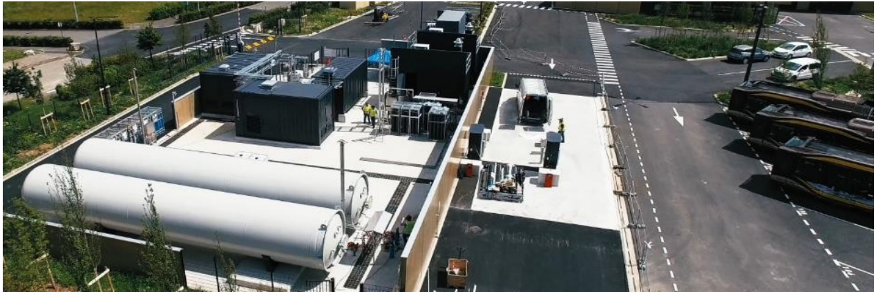
Haut de France, projet « SMT-AG » : première station hydrogène zéro-carbone pour bus en France (200 kg d'hydrogène / jour, 0,5 MW d'électrolyse).
