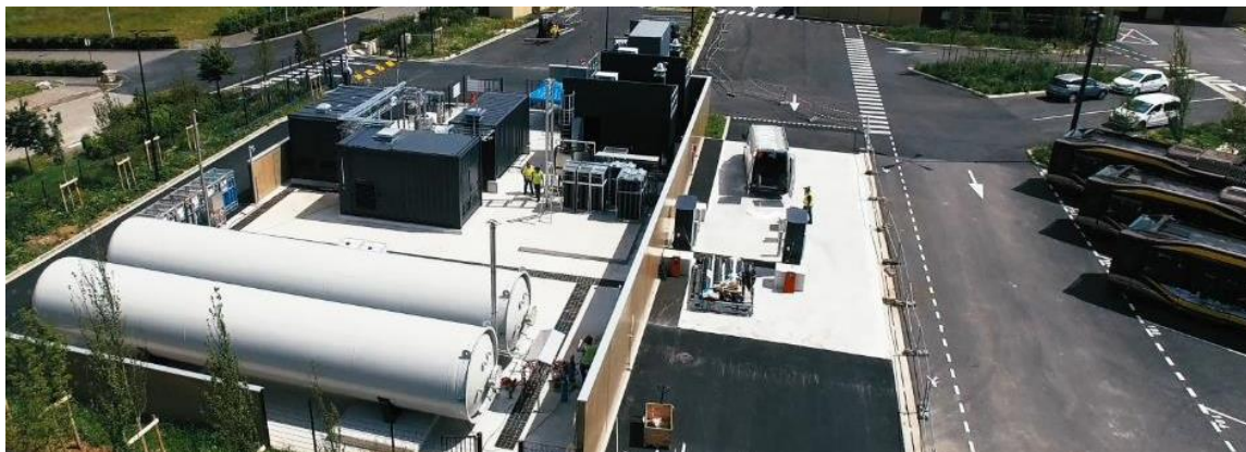
Haut de France : première station hydrogène zéro-carbone pour bus en France (200 kg d'hydrogène / jour, 0,5 MW d'électrolyse).
