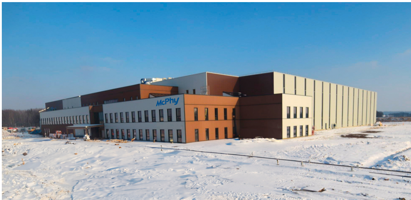
La Gigafactory McPhy, un outil stratégique pour le déploiement industriel de la production en série d'électrolyseurs de nouvelle génération.
